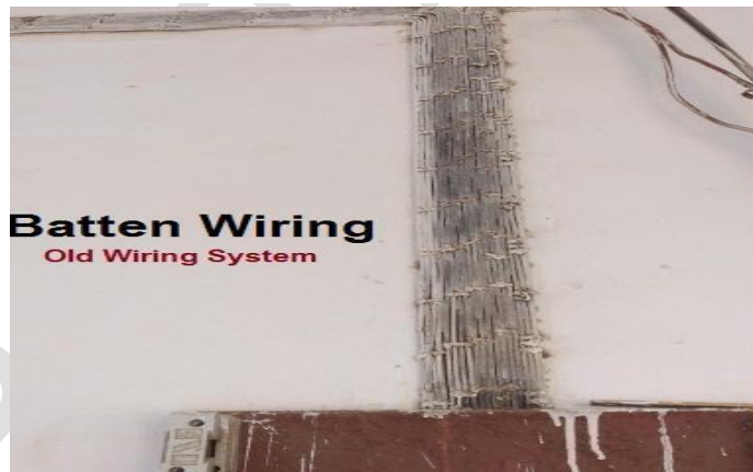
(Fig.5.3. Batten Wiring)
